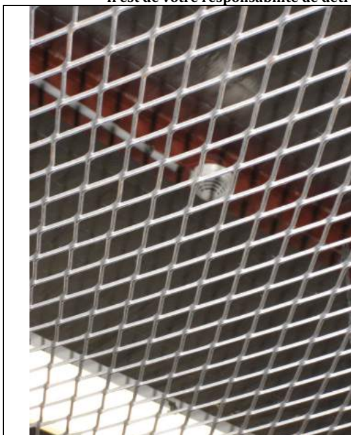
Figure 7: Toiture + systèmes anti projection
